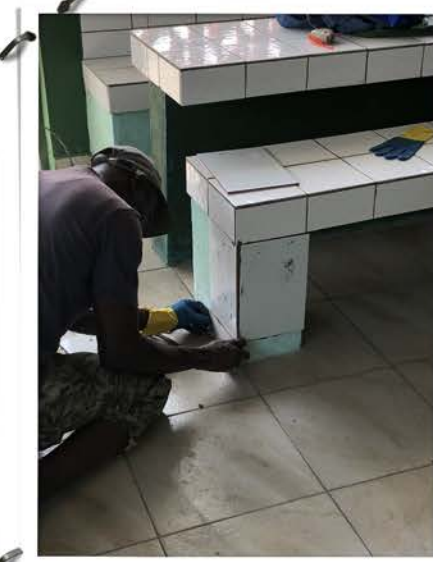
Pose de carrelage sur les supports tables et bancs.
